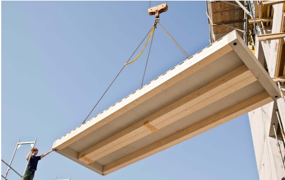
Bild I-7 Herstellung von Holz-Beton-Verbunddecken nach Option A 25
