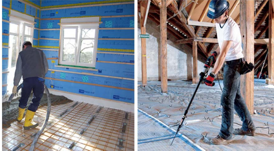
Bild I-9 Herstellung von Holz-Beton-Verbunddecken nach Option C (links) und Option D (rechts) 27
